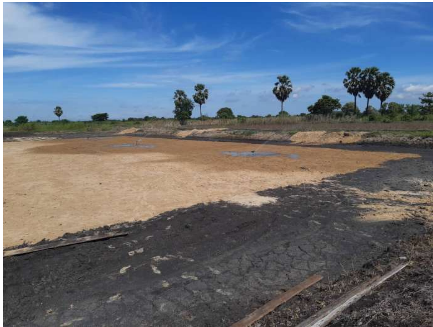
植付後散水状況
