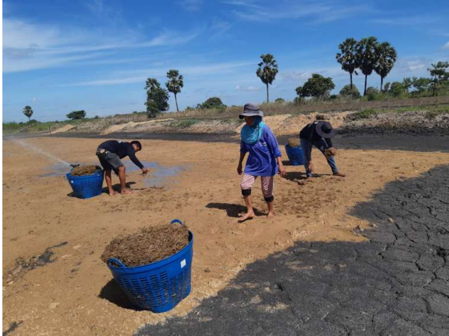
約2500㎡にまき芝にて施工
